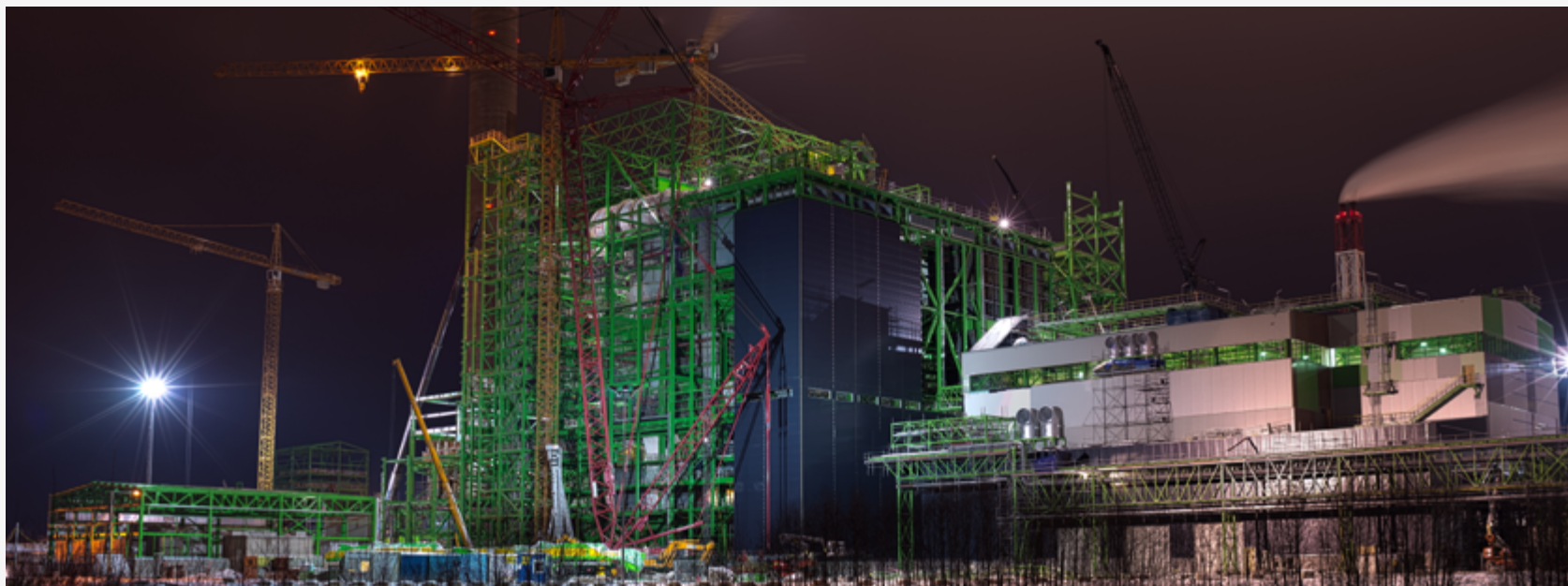
2014. AASTAL VALMIV TÖÖSOLEV SUUROBJEKT: IDA-VIRUMAAL AUVERES EESTI ELEKTRIAAMA TERRITOORIUMILE RAJATAVA PÕLEVKIVI JA BOKÜTUSE ETTEANDESÜSTEEMIDE ELEKTRISÜSTEEMIDE EHITUSTÖÖD KOOS VAJALIKE SEADMETEGA.
