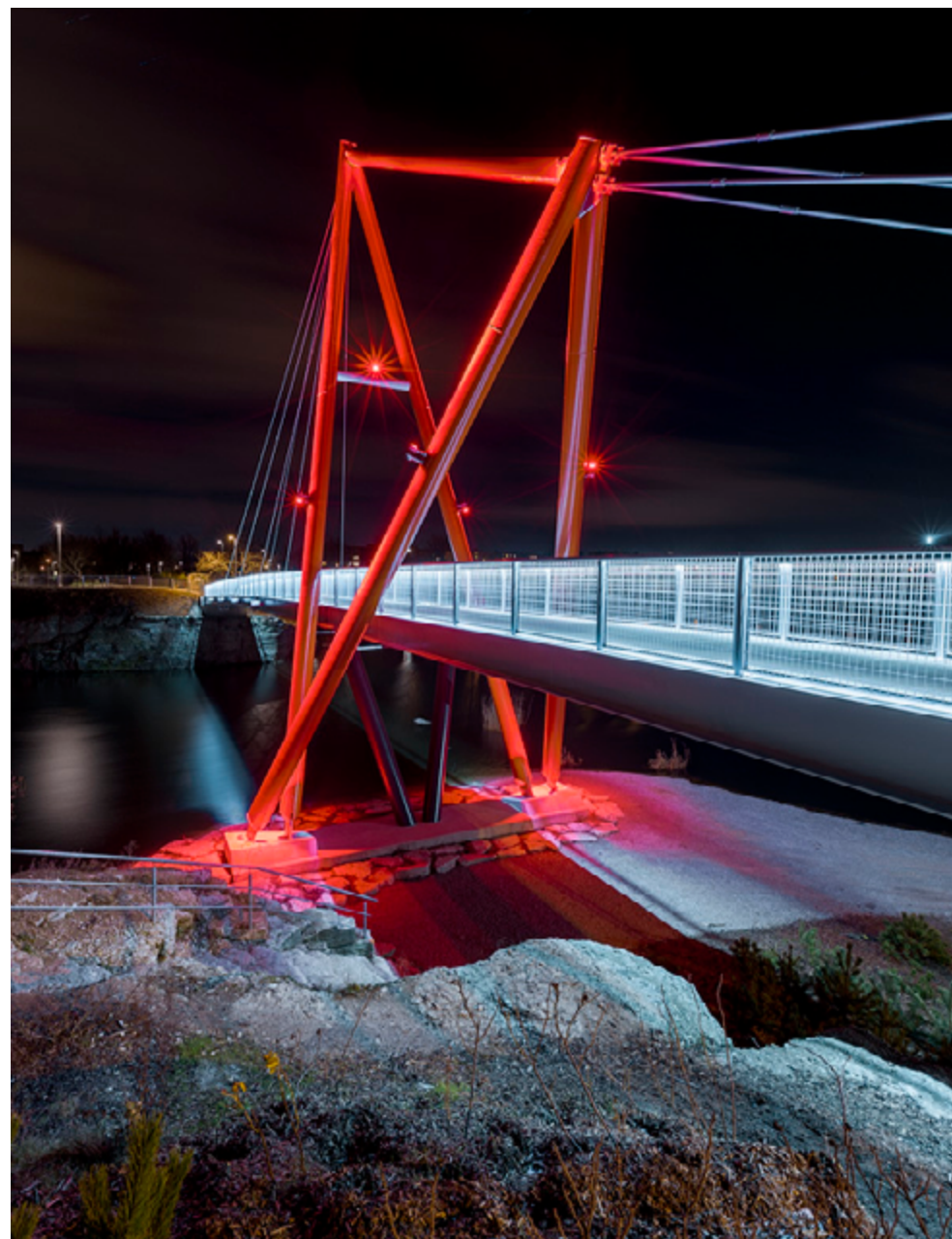
2013. AASTAL VALMINUD PAEPARGI SILLA PUHUL ON PÖÖRATUD OLULIST TÄHELEPANU ARHITEKTUURILE NING PIMEDAS TOOVAD SILLA SILUETI EFEKTSILT VÄLJA LED-RIBAD JA LED-PROJEKTORID.
