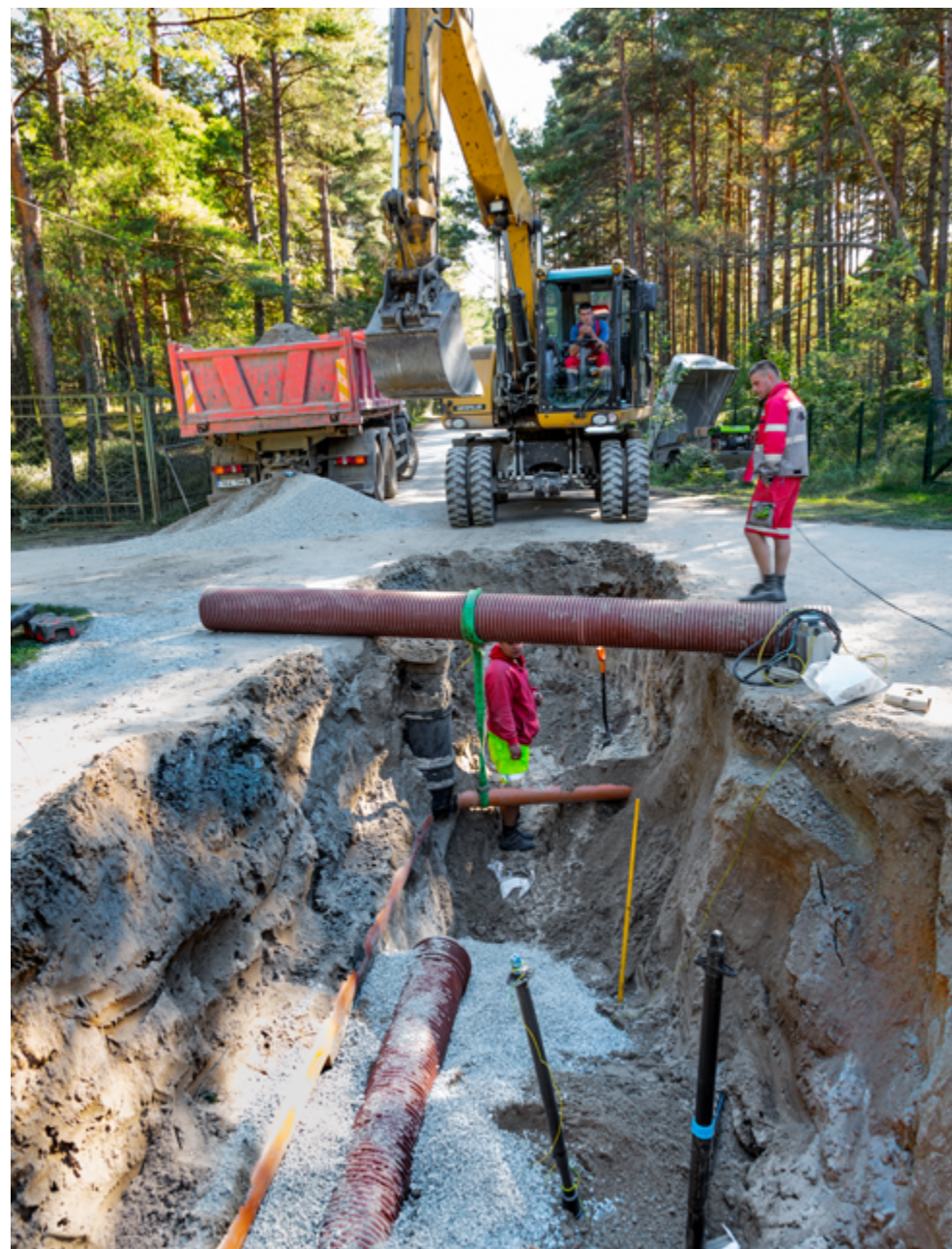
VÄÄNA-JÕESUU VEE- JA KANALISATSIOONITORUSTIKE TÖÖDE RAAMES PAIGALDATI KOHATI ÜLE 20 KM TORUSTIKKU KUUS.
