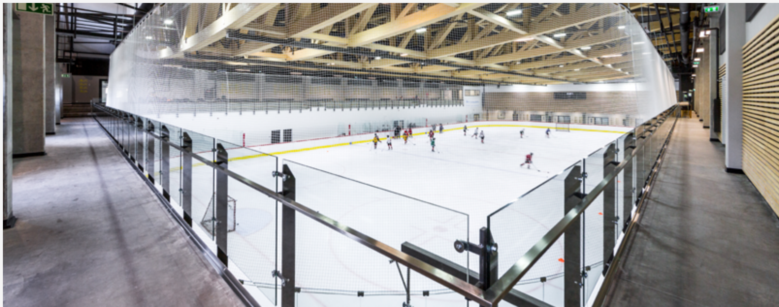
2014. AASTAL 14 KUUGA MERKO PROJEKTITUHT AHTO ARUVÄLI JUHTIMISEL VALMINUD MULTIFUNKTSIONAALNE TONDIRABA JÄÄHALL, MIS HÕLMAB PEAAREENI, KAHE HARJUTUSVÄLJAKUT NING CURLINGU VÄLJAKUT. FOTOL IMPOSANTSSED, KUNI 62 MEETRI SILDEGA PUITFERMID.
